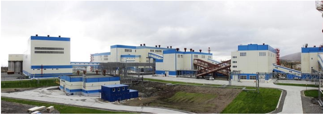
1.5 сурет – Ұнтақтау-ұсақтау фабрикасы
